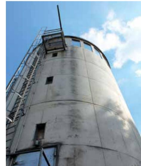
Silo für Resthölzer, die das Betriebsgelände mit Wärme versorgen
